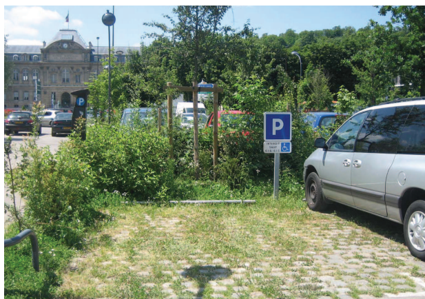
Stationnement de véhicules au sol perméable
